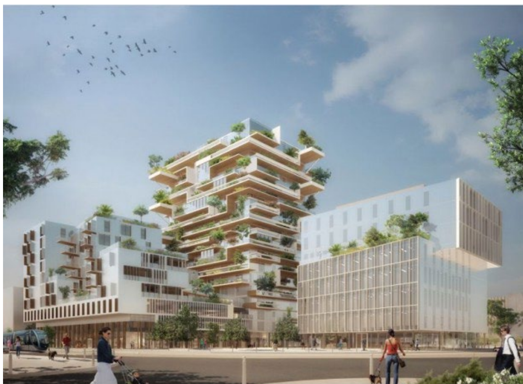
Construction bois sur 57 mètres de haut de 82 logements à Bordeaux © Jean-Paul Viguier & Associés
